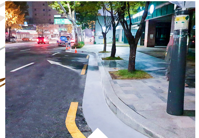
① 종로구 율곡로 171 측구 보수 공사
