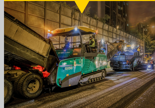
차로별 근접(3~5m)시공으로 1,2차로 접속부 시공조인트 미발생
