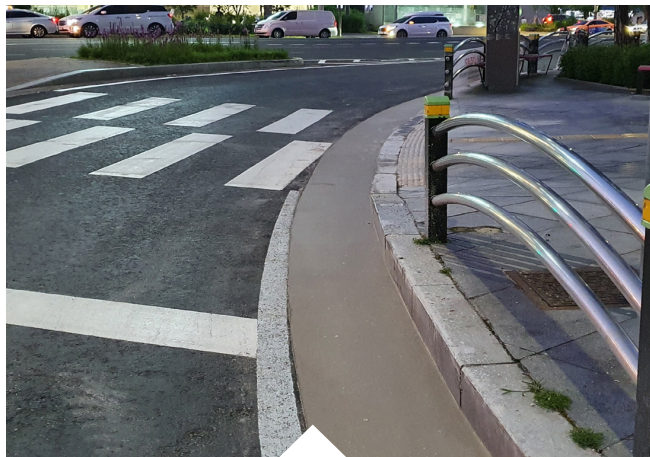
③ 을지로 5가 주변 측구 보수 공사
