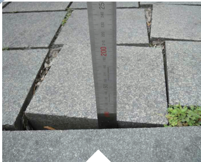
④ 줄눈부 및 받침부 유실
