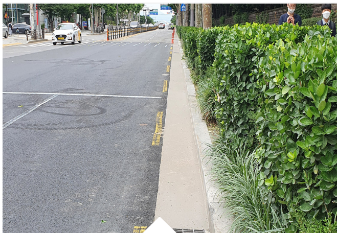
② 강남 수서 경찰서 주변 측구 보수 공사
