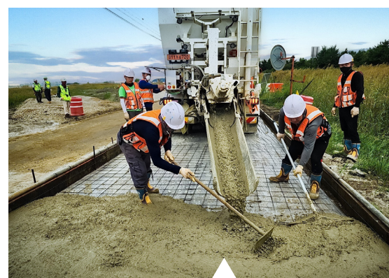
초속경 콘크리트 타설
