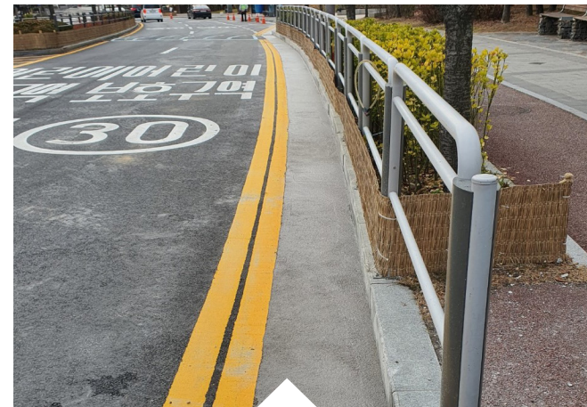
④ 강남구 세곡동 주변 측구 보수 공사
