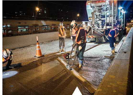
한강교량 LMC 콘크리트 타설
